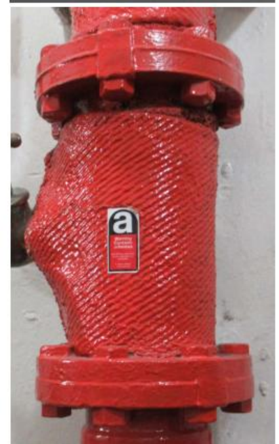
Asbest binnen een erfgoedcontext is soms beheersbaar. De kruiser HMS-Belfast, een van de topattracties van de Imperial War Museums, licht bezoekers in over het aanwezige asbest en vraagt om niet aan de leidingen te komen. Het asbest, vaak aanwezig als isolatie van pijpleidingen, kreeg een extra omhulsel van glasvezel, waardoor het uitzicht bijna ongewijzigd bleef.
